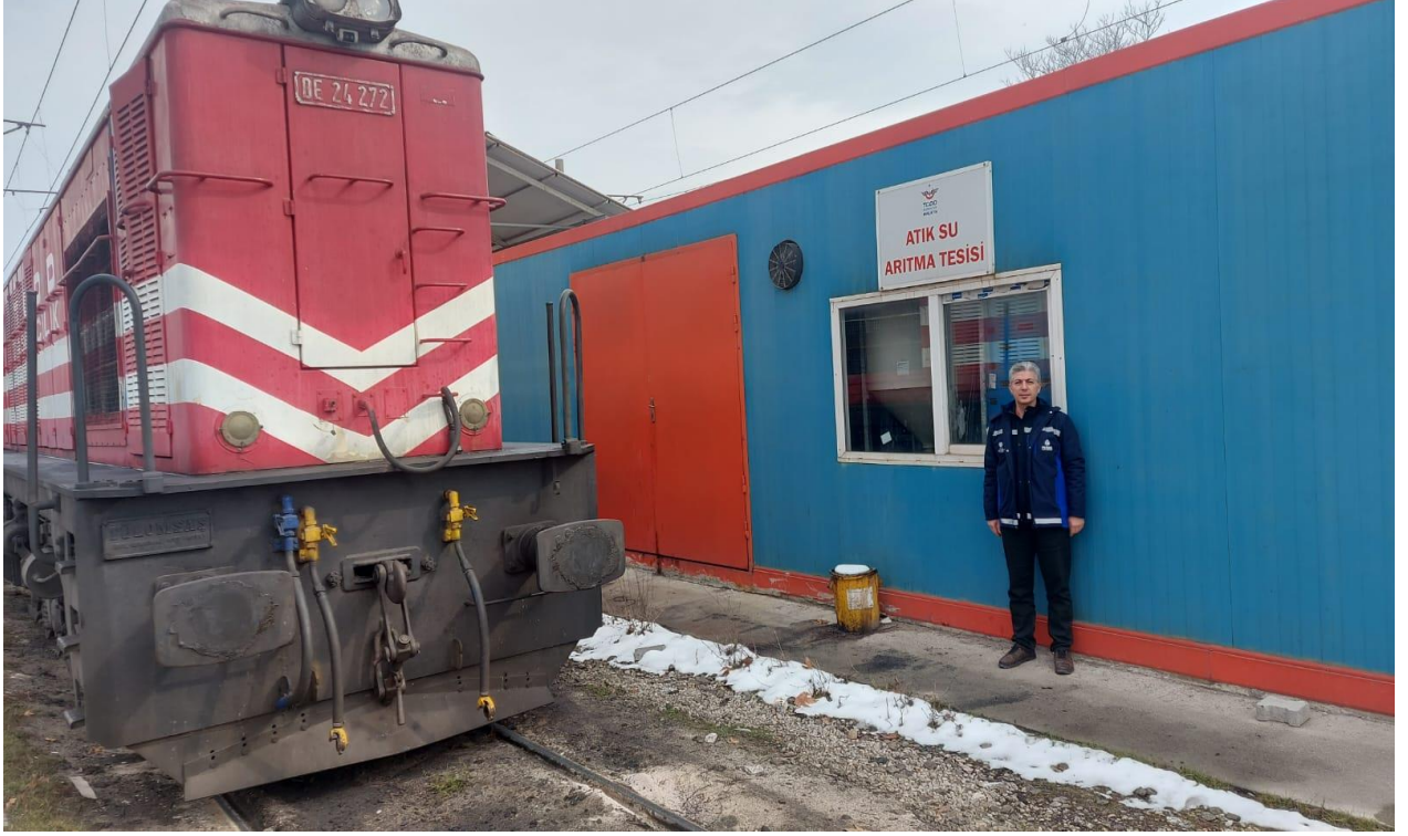
TCDD Lokomotif İşletme Atölyesi Paket Atıksu Arıtma Tesis
